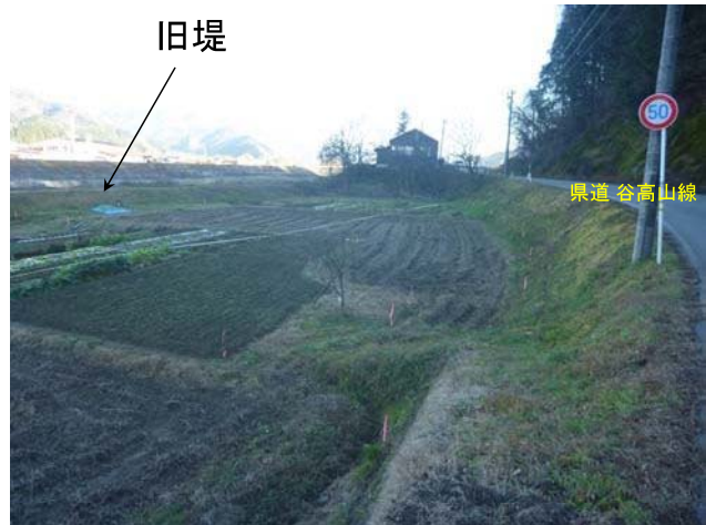
引堤部築堤着工前
