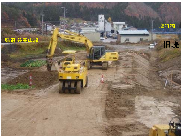
引堤部築堤施工状況
