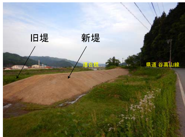
引堤部新堤施工状況
