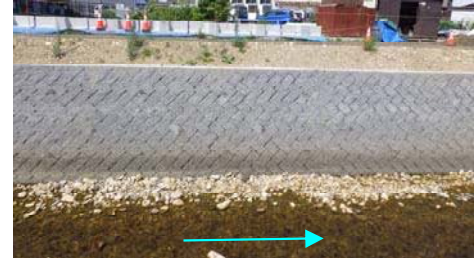
寄せ石及び護岸の状況
