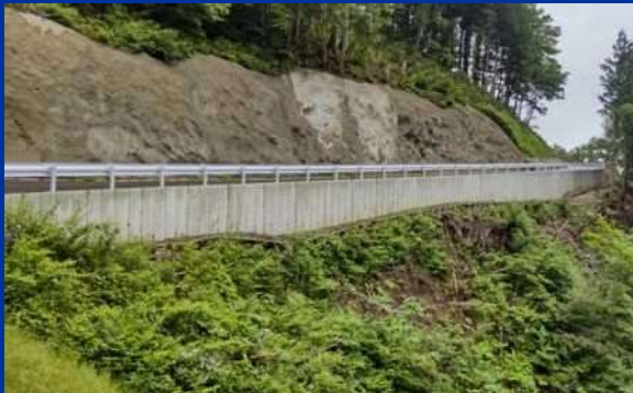
プレキャストL型擁壁工
