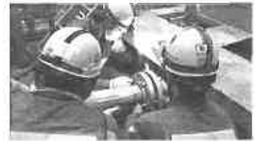
現場実働訓練 (緊急発生器補給用板倉中にポンプの補助結束系統への接続)
