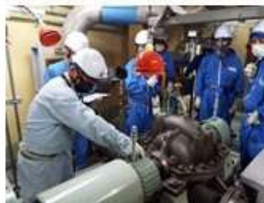
【回転機器の振動確認の状況】
