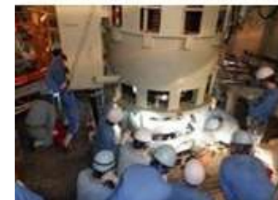
【現場パトロールの状況】
