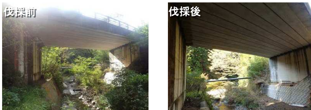
付録 3-図 3.3 桁下の状況
