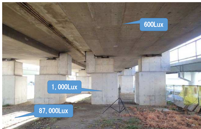
付録3-図3.2 PC床版橋下面の照度計測値
