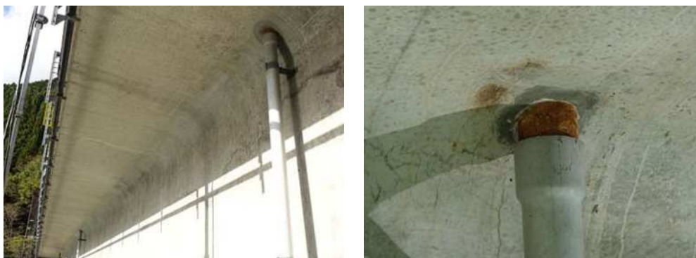
付録 3-図 3.7 排水管撮影事例
