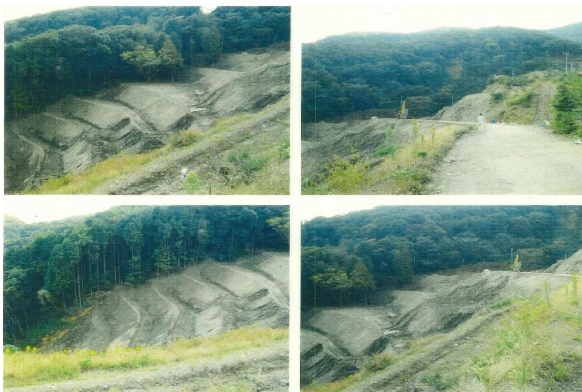
写真-8 2010年10月18日 前所有者による土砂搬入と土地整形が終了したと推定される状態
