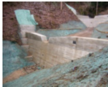
治山ダム(下呂市)
