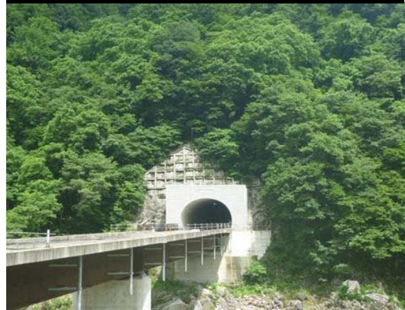
(仮称) 宮川2号トンネル貫通後の状況 (R2.7)
