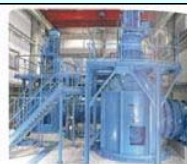
平野井川排水機場
