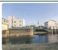
柳瀬排水機場
