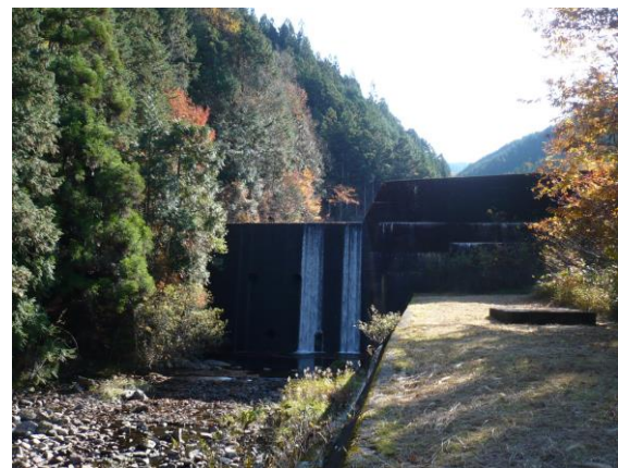
下流の取水堰堤（東白川村）
