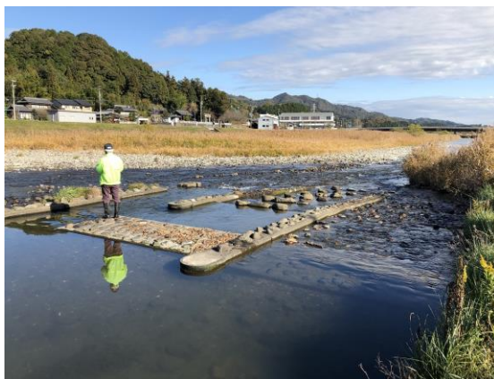
FWSによる魚道点検状況【武儀川（山県市）】
