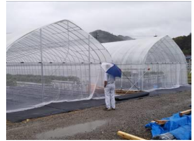
【新設育苗ハウス】
