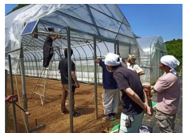
【ハウスに機器を設置】
