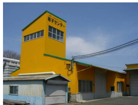
改修された種子センター
