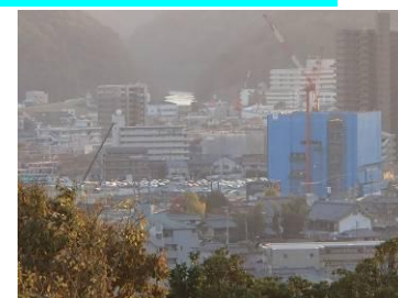
【多治見駅北再開発地に建設が進む、直売所入居予定のビル（写真右端中央）】
