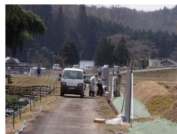
【北小木地区 機械化営農組合員らによる獣害防止柵設置作業】
