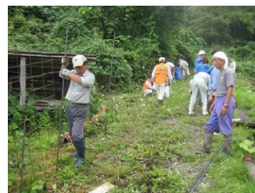
【地域住民の力を合わせて防護柵を設置】
