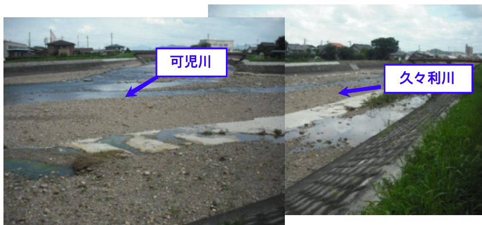
図 8 - 1 6 . 久々利川合流点における7.15豪雨後の土砂の堆積状況 (平成22年7月29日撮影)
