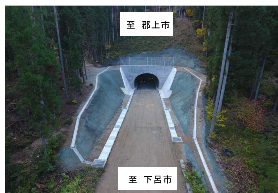
(主)金山明宝線 畑佐・小川峠工区 工事状況
