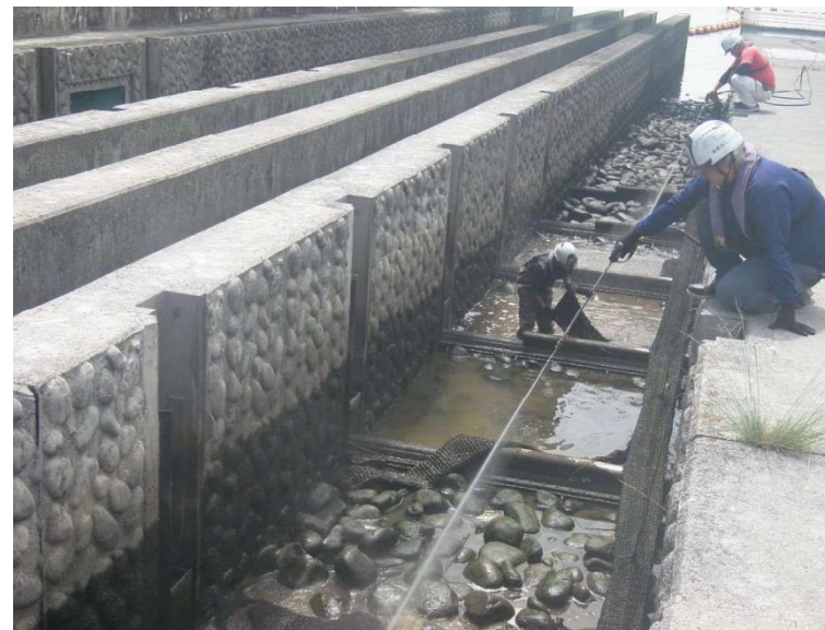
右岸呼び水式魚道の清掃状況 （令和2年5月）
