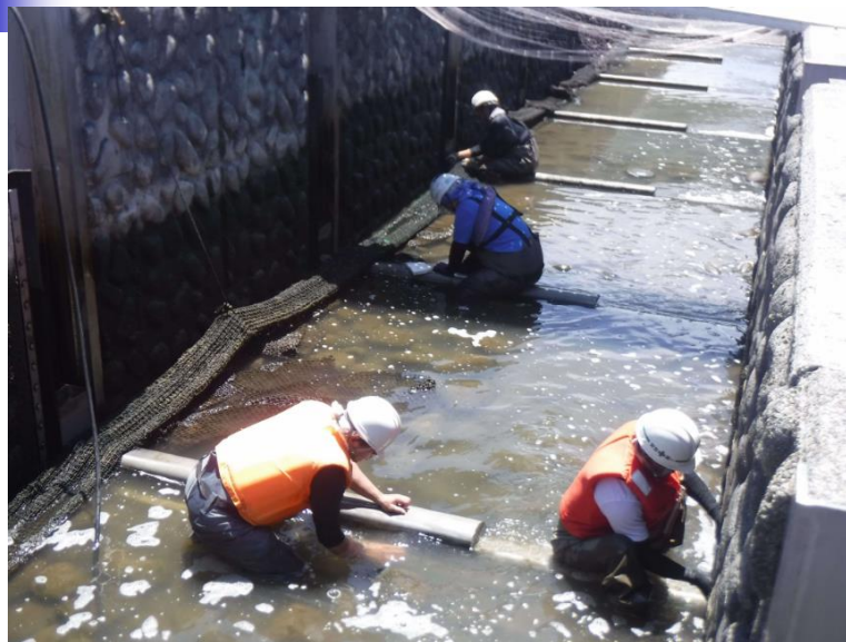
左岸呼び水式魚道の清掃状況 （令和2年6月）
