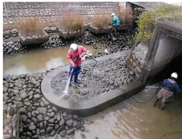
右岸せせらぎ魚道の清掃状況 （令和2年2月）
