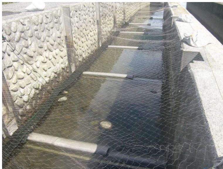
呼び水式魚道への防鳥ネットの設置状況 （令和2年3月）
