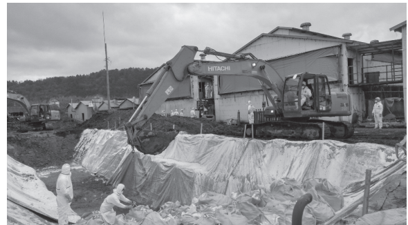
<防疫措置（埋却作業）>
