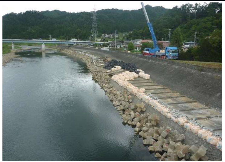
応急工事完了後
