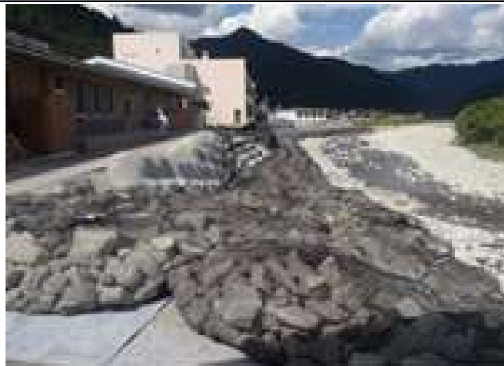
応急工事完了後
