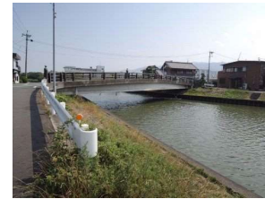
調査地点8: 渡橋付近
