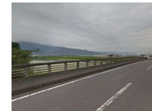
調査地点: 石亀橋
