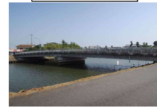
調査地点c: 築留橋
