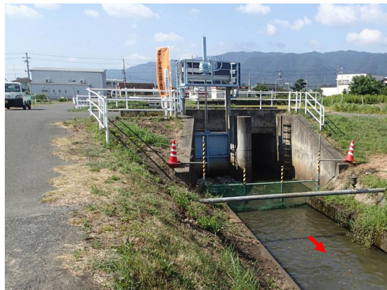
写真 3.9 水門の開放状況（H28 実施）
