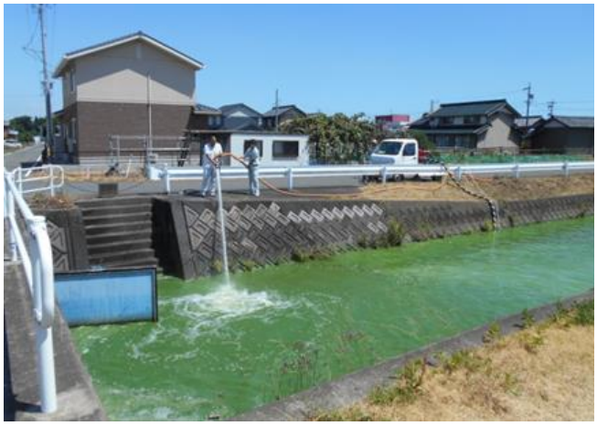
写真 3.1 高圧水放水による攪拌作業状況(H30)
