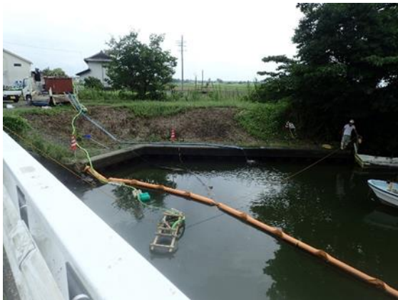
写真 3. 4 水中ポンプによる水の汲み上げ(H28、H30、R1 実施)
