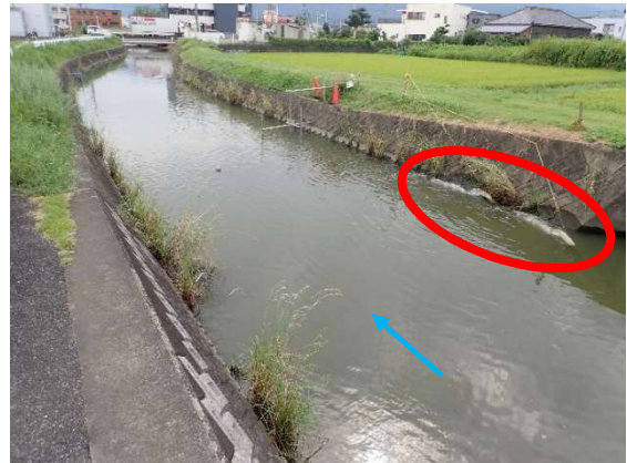
対策区 (9月8日 14:30以降) (右岸に2機設置)
