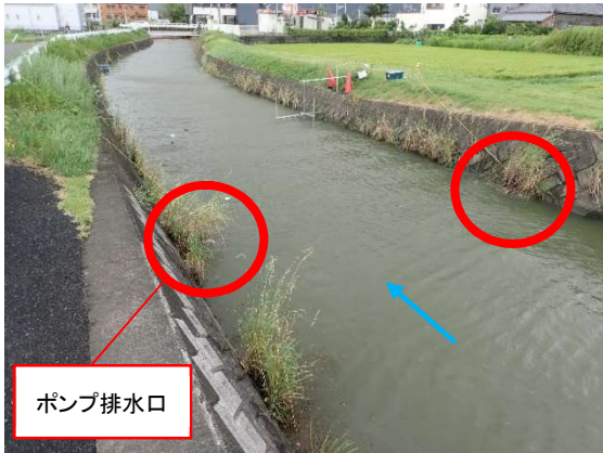
対策区 (9月7日 8:00~9月8日 14:30) (両岸に1機ずつ設置)
