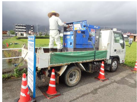
水中ポンプ電源 (発電機)
