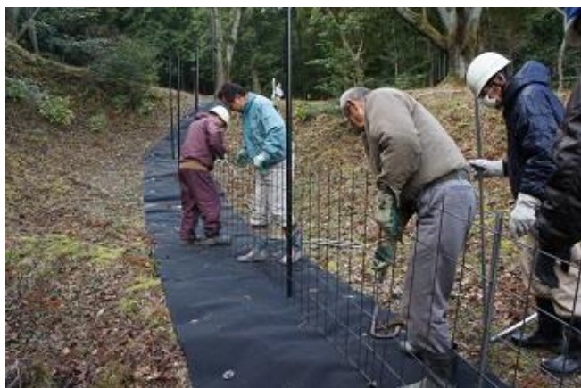
鳥獣防護柵設置状況
