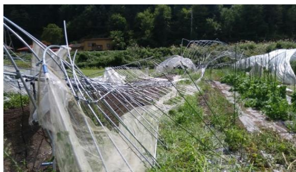
風水害によるパイプハウスの倒壊
