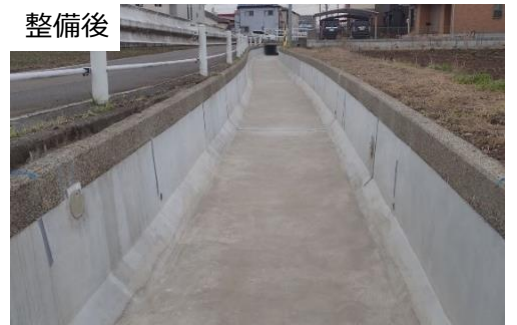
農業用水路の予防保全対策 (関市 曾代用水四期地区 曾代用水)
