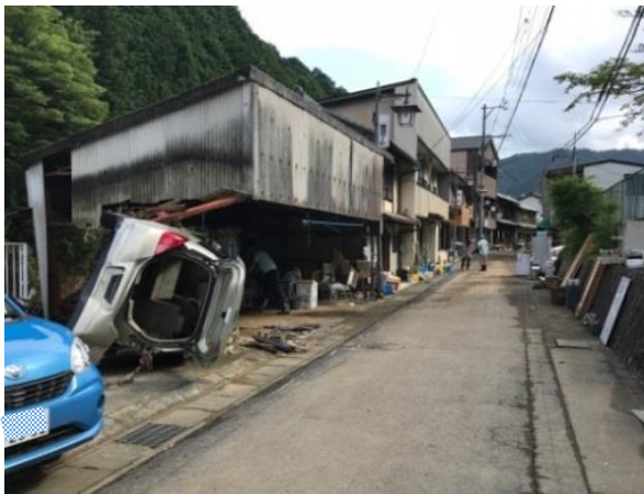
図 6-15 平成 30 年 7 月豪雨災害 (関市上之保地内 浸水害状況)
