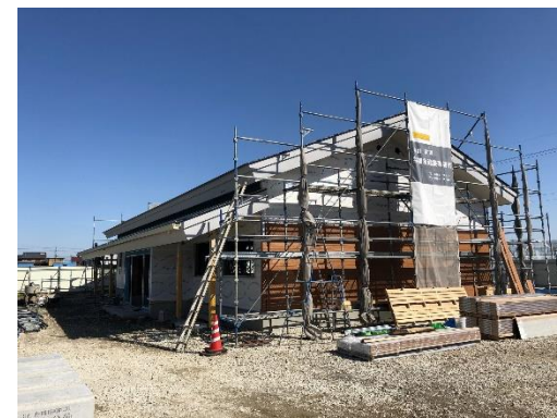
オペレーションセンター(整備中)
