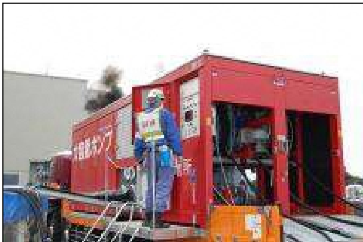
<大容量ポンプ起動訓練>
