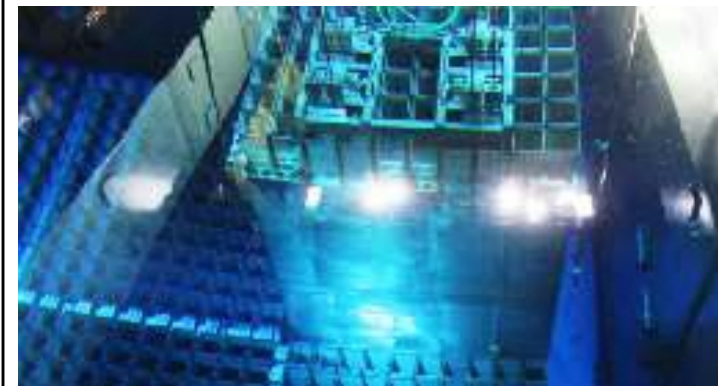
使用済燃料ピットラック (吊込み中)
