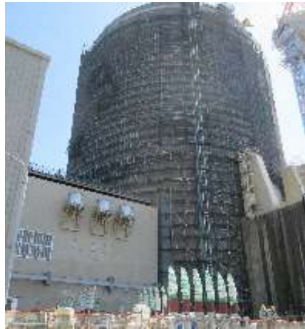
外部遮へい壁上部の補強工事状況
