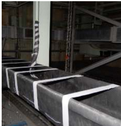
<防火シート施工箇所>
