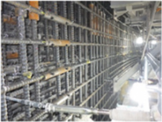
鉄筋追加設置状況
