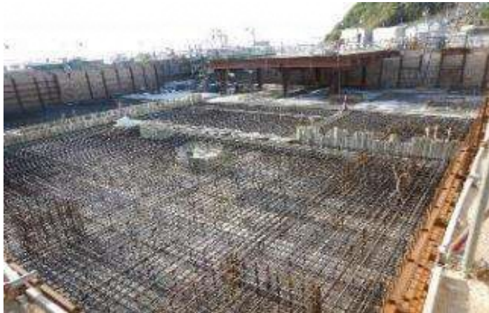
基礎工事の様子
