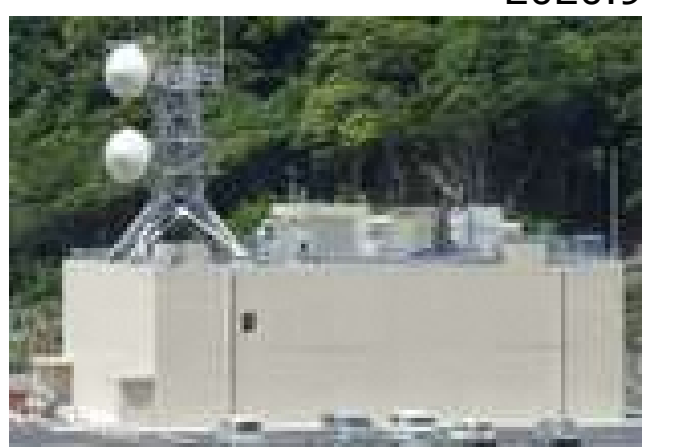
完成後の現在の状況
