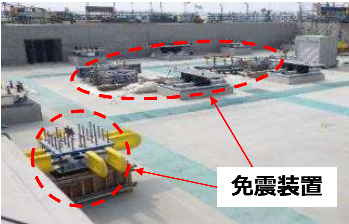
免震装置設置の様子
