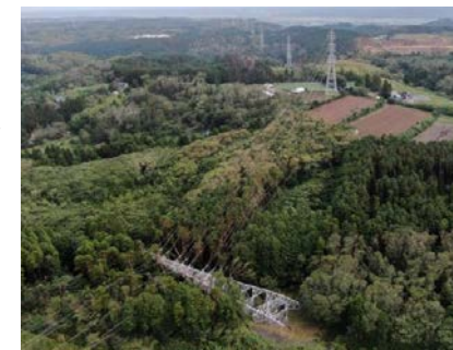
鉄塔設備の倒壊（君津市）
