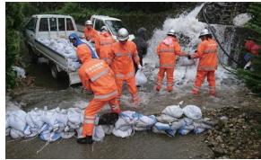
道路や民家への流入を防ぐ土の積み
