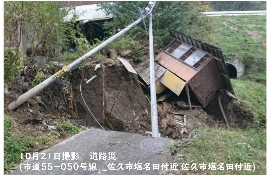
10月19日撮影 下水道災 (千曲川第4-1号雨水幹線_小布施町大字山王町付近)
