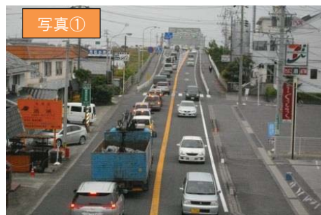
整備前(混雑状況)
