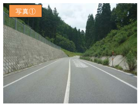
整備後（2車線整備）
