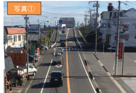
整備後(混雑解消状況)
