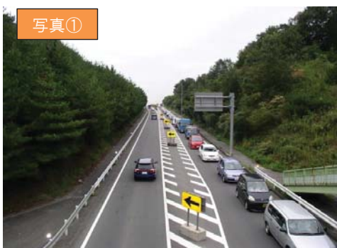
整備前（混雑状況）
