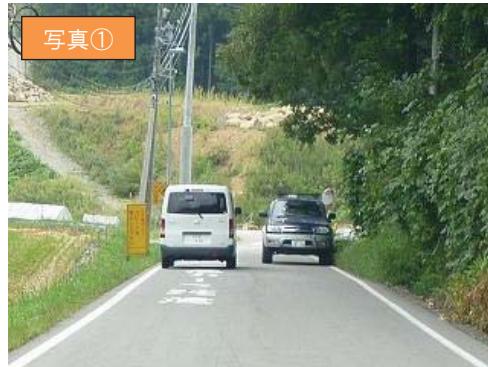
整備前（幅員3.6m区間）
