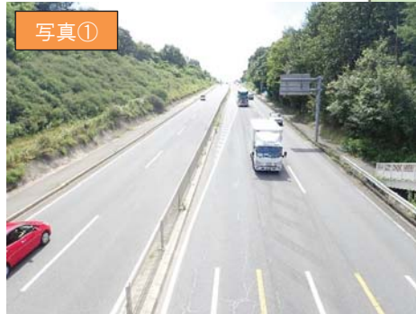
整備後（混雑解消状況）
