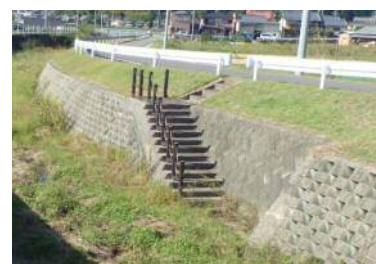
親水階段工の設置
