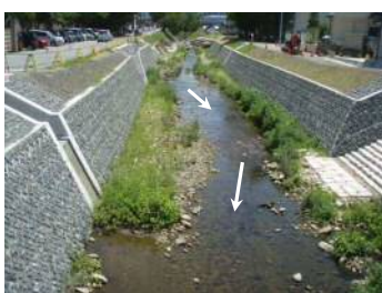
改修時にみお筋を設置
