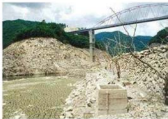
枯渇した岩屋ダム(水資源機構提供)
