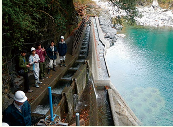
FWSによる魚道点検状況【根尾川(本巢市)】
