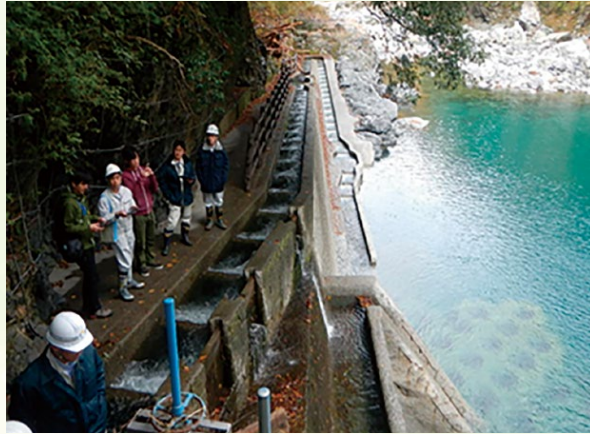
FWSによる魚道点検状況【根尾川(本巣市)】
