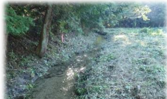
用排水兼用の土羽水路
