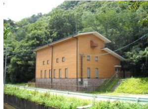
伊木山揚水機場
