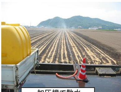
加圧機で散水
