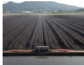
整備後の散水状況
