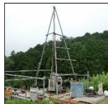
ボーリング調査
