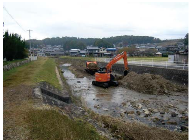
河道掘削状況
