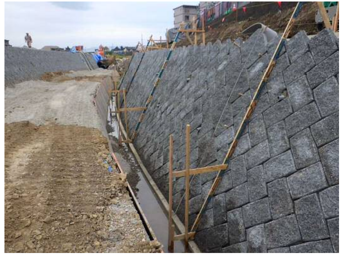
護岸ブロック積み施工状況
