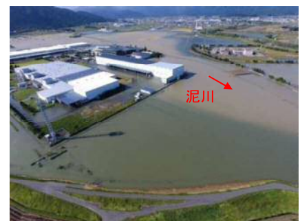
H29.10豪雨 浸水状況
