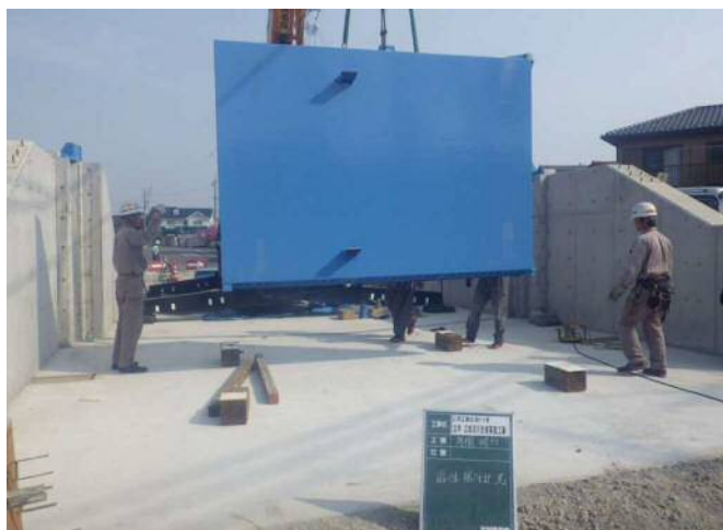
陸閘扉体据付状況
