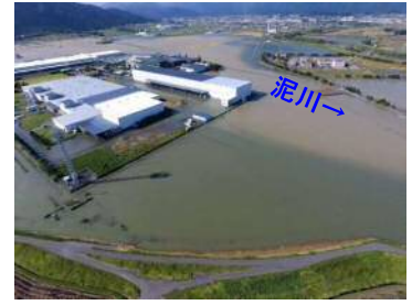
平成29年10月 浸水状況
