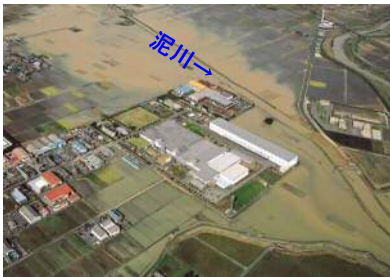
平成14年7月 浸水状況
