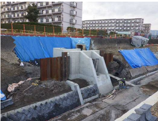
樋管工施工状況
