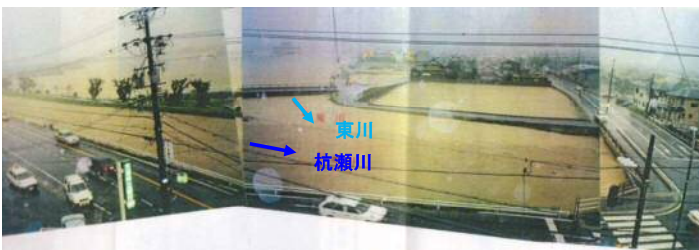
H14.7豪雨 浸水状況(東川合流点付近)
