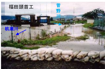
H14.7豪雨 浸水状況(笠木地区付近)
