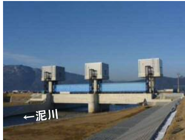
平成23年3月 泥川水門完成
