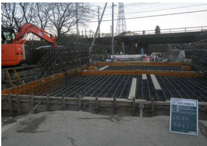
▪基礎型枠設置状況
