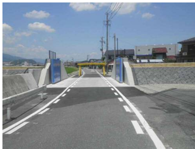
笠木陸閘完成状況
