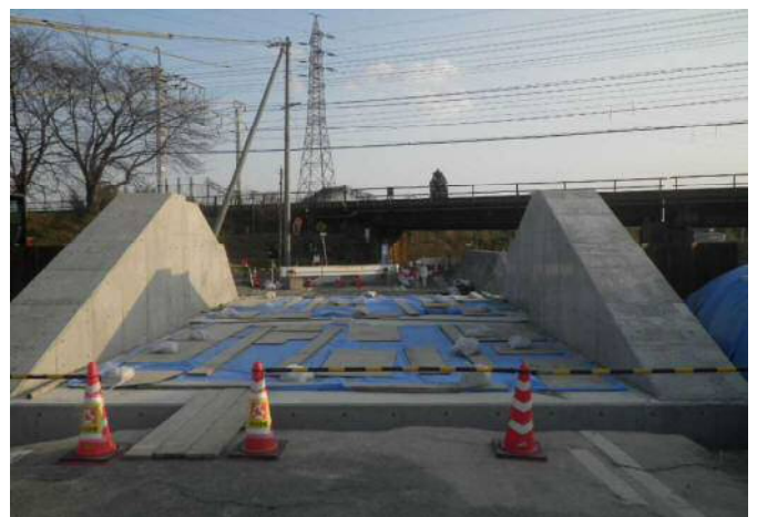
▪コンクリート打設完了
