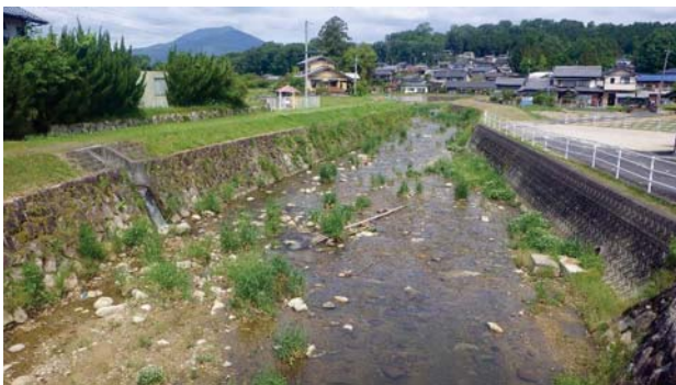
河道掘削施工後
