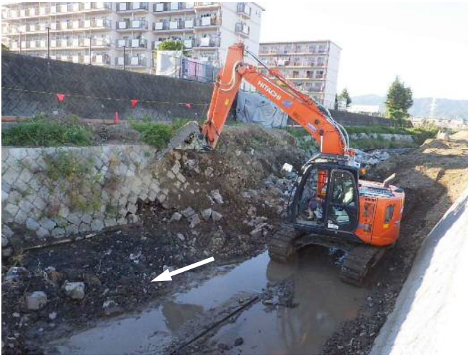
既設護岸取壊し状況
