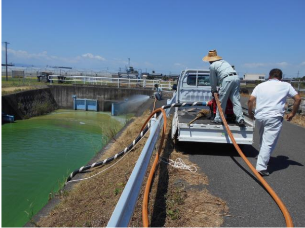
写真 3.1 高圧水放水による攪拌作業状況(H30)
