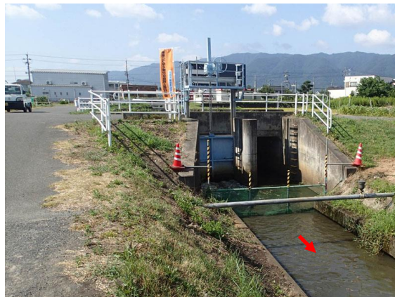
写真 3.8 水門の開放状況（H28 実施）
