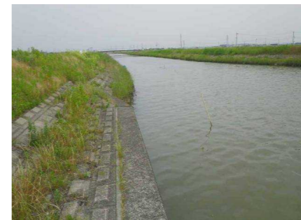
調査地点3: 導水地点より約1.5km下流付近
