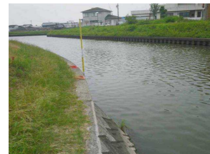
調査地点7: 馬目橋付近
