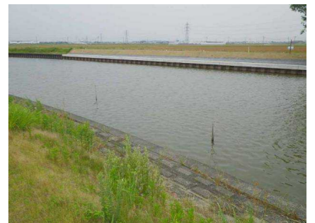
調査地点4: 導水地点より約2.0km下流付近
