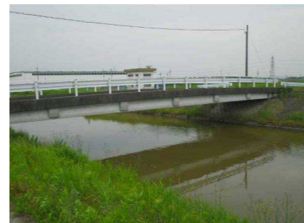
調査地点1: 上一色橋付近
