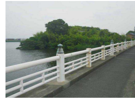
調査地点10: 万寿橋付近
