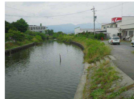
調査地点6: 海洋明誠高校付近
