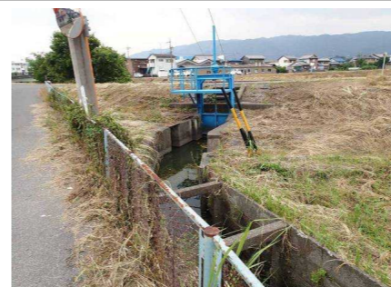
調査地点b: 流入水路(地点8付近)
