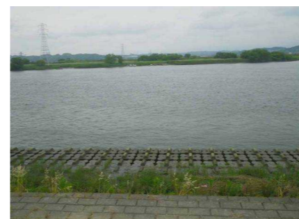
調査地点B: 揖斐川・大江川合流点下流
