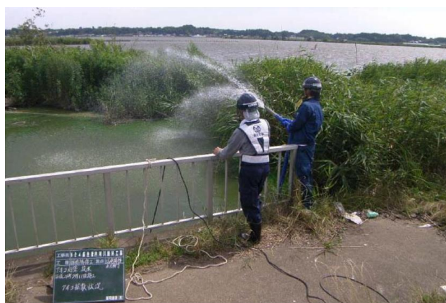
写真－1 放水による攪拌のイメージ
