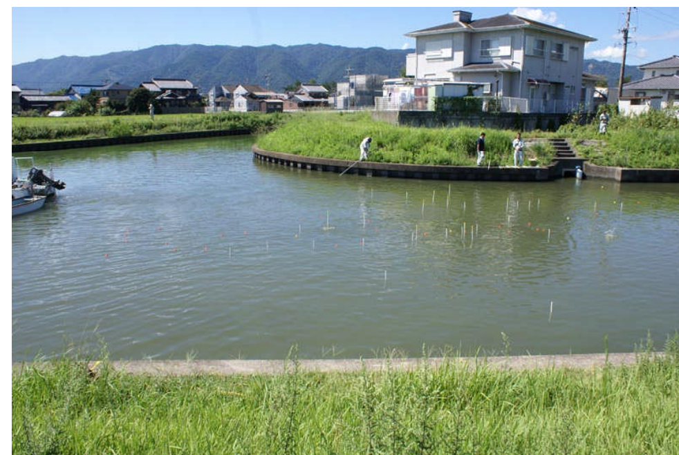
写真② 「浮き」による水流の発生状況の確認
