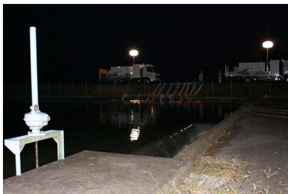
土倉揚水機場貯水池からの取水
