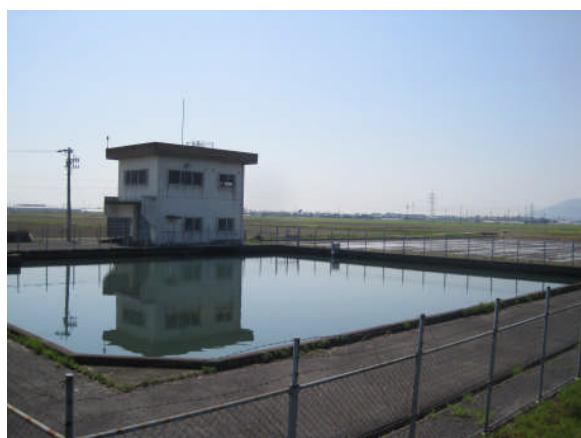
土倉揚水機場と貯水池
