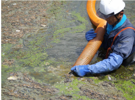
H22.9.2 バキュームによる除去作業
