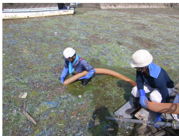
H22.9.2 バキュームによる除去の状況
