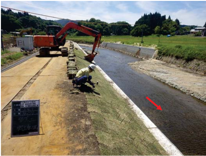
張芝工施工状況
