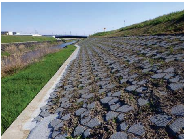
客土に現場発生材を使用した護岸ブロック
