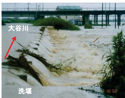
H14.7豪雨 浸水状況
