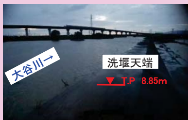
平成29年10月23日(5:50) 洗堰水位状況(TP8.83m)
