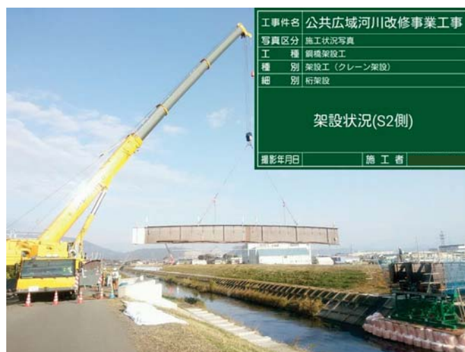
菰田橋上部工架設状況
