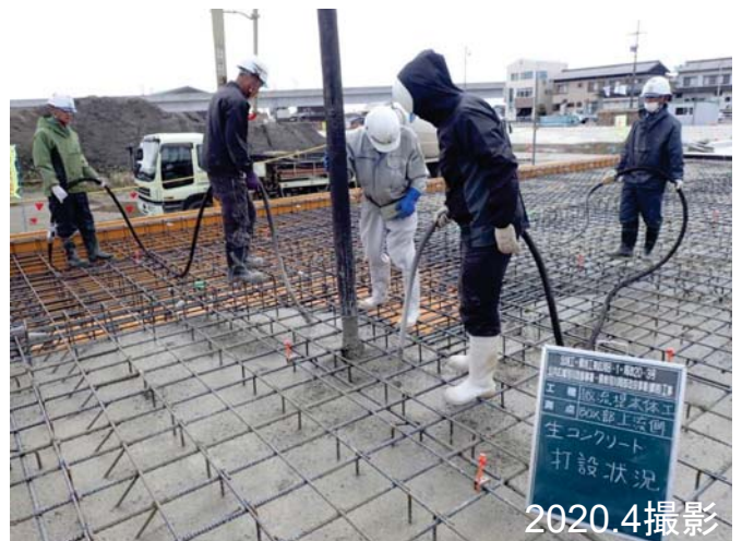
越流堤(上流側)の打設状況
