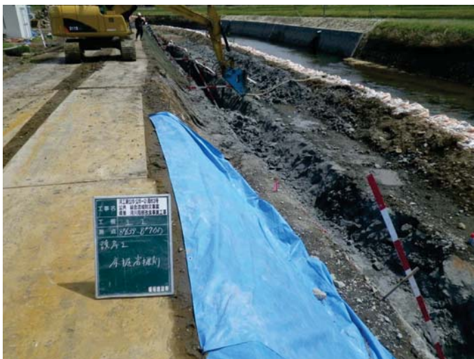
掘削工(床掘)施工状況
