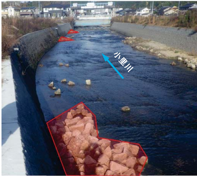
自然環境に配慮した施工の状況(8k8付近)
