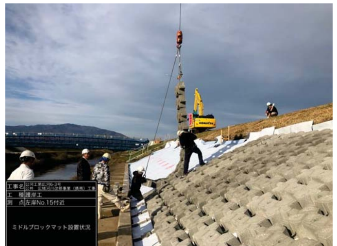
連節ブロック張工敷設状況
