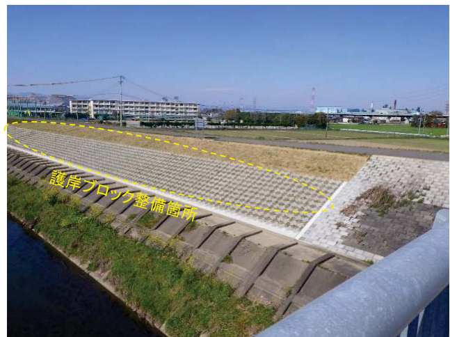
客土に現場発生材を使用した護岸ブロック
