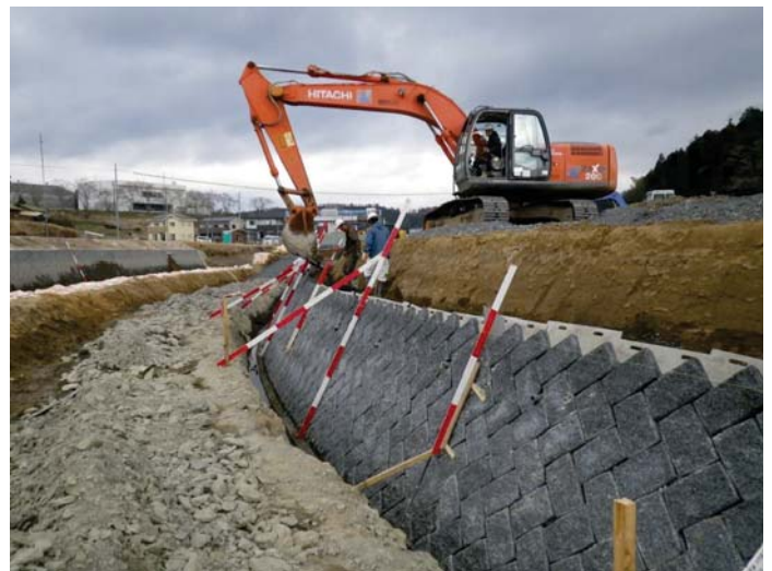
ブロック積施工状況
