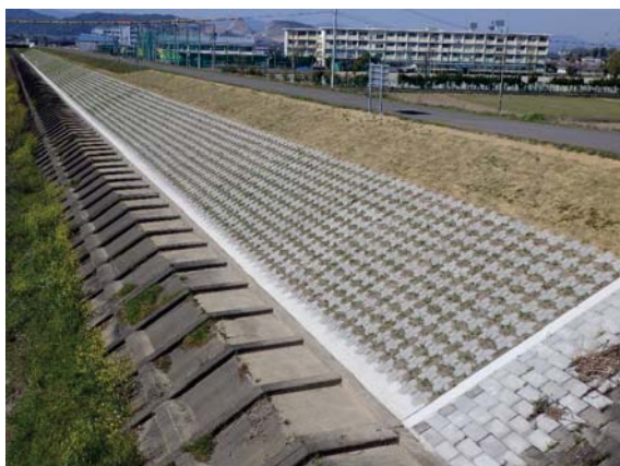
高水護岸整備状況
