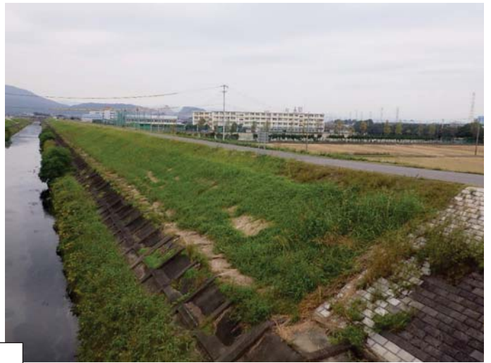
漏水対策護岸着工前
