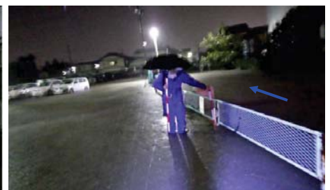
上牛屋橋下流(10.55k付近)の浸水状況 平成29年10月22日洪水
