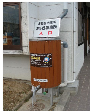
図—16 貯留・浸透施設の設置
