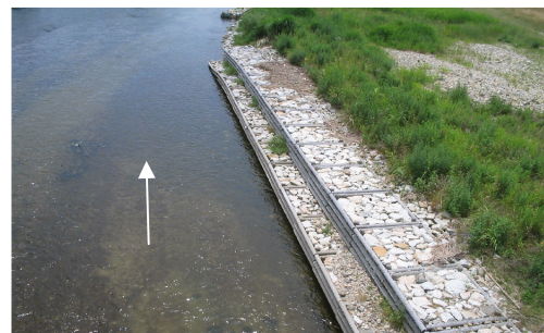
図一14 木工沈床の整備 (土岐市土岐津町)
