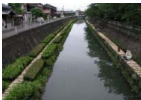
水際部の環境に配慮した護岸 （新規川）
