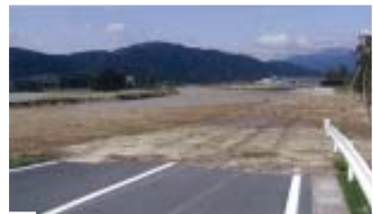
泥川 養老町室原 (泥川橋より上流)
