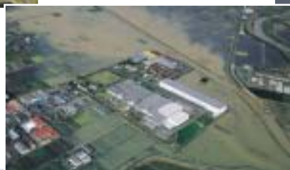
養老町室原地区の 浸水状況
