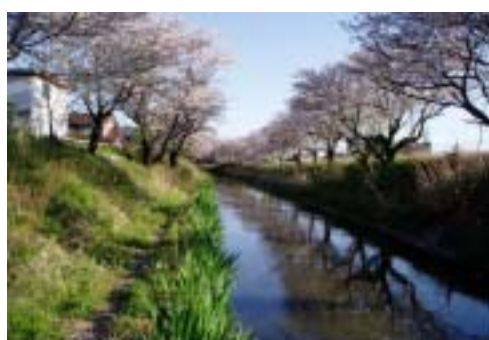
ホタルの生息に配慮した 河川事業（奥川）
