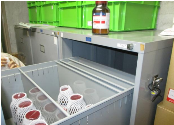
西濃保健所（安定ヨウ素剤の保管庫）
