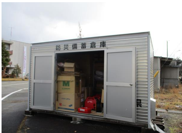
飛驒総合庁舎敷地内の防災備蓄倉庫
